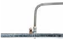
SPRINKLER CON LATIGUILLO FLEXIBLE
