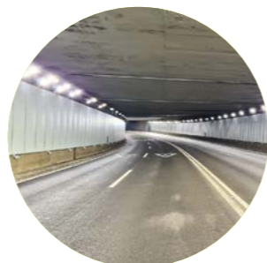
Túnel Bonanova Barcelona
