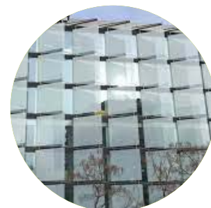
Edificio de Oficinas Suero de Quijones, 42
