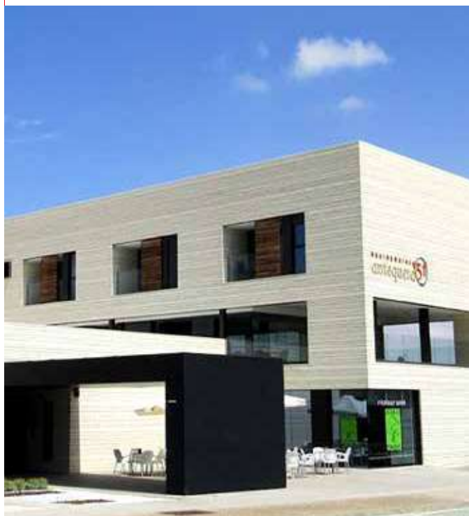
Residencial Antequera 51 "Cohousing" (Málaga) Sistema instalado: Q-TON Bomba de calor con CO 2 + KXZ Bomba de calor (VRF)
