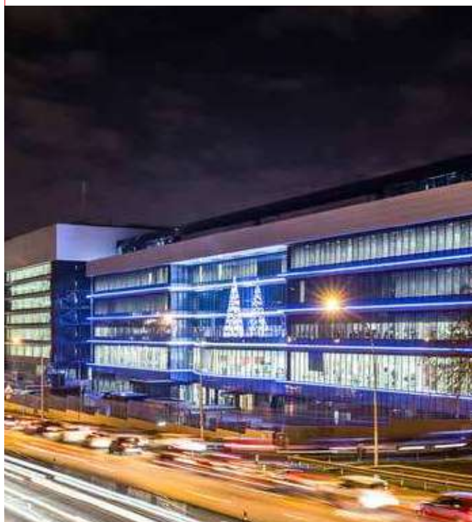
Edificio Oficinas Torre Rioja I y II (Madrid) Sistema instalado: Q-TON Bomba de calor con CO 2
