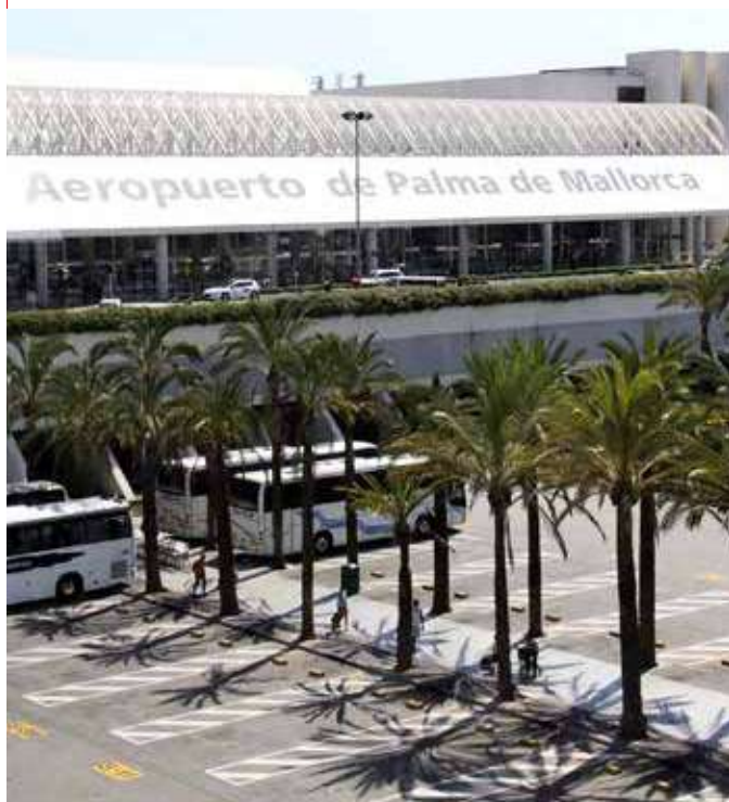
Ampliación Aeropuerto de Palma de Mallorca Sistema instalado: Gama PAC (Semi-Industrial)
