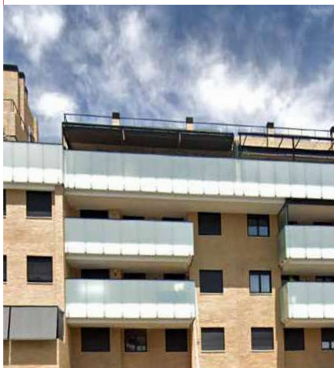
Edificio de 124 viviendas en Pinto (Madrid) Sistema instalado: Q-TON Bomba de calor con CO 2
