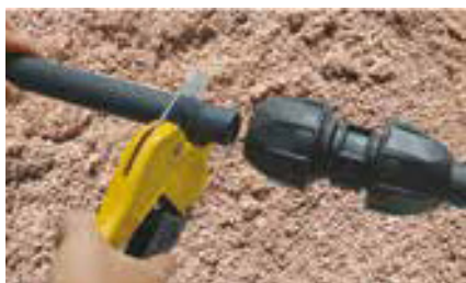
1. Cortar el tubo.
