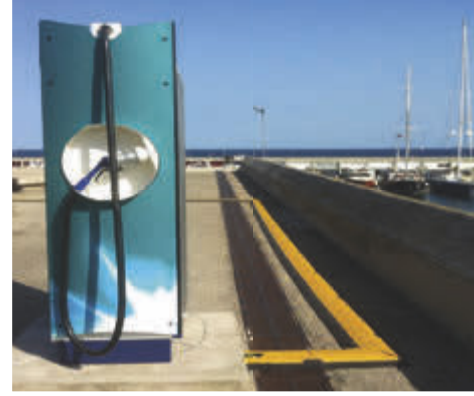
Casa sostenible - Port de Barcelona
