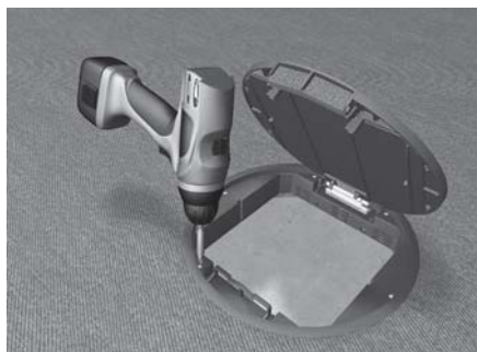
Fijar la tapa con los 4 tornillos de fijación.
