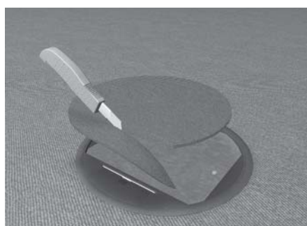
Recortar el revestimiento del suelo según las dimensiones de la tapa de la caja.
